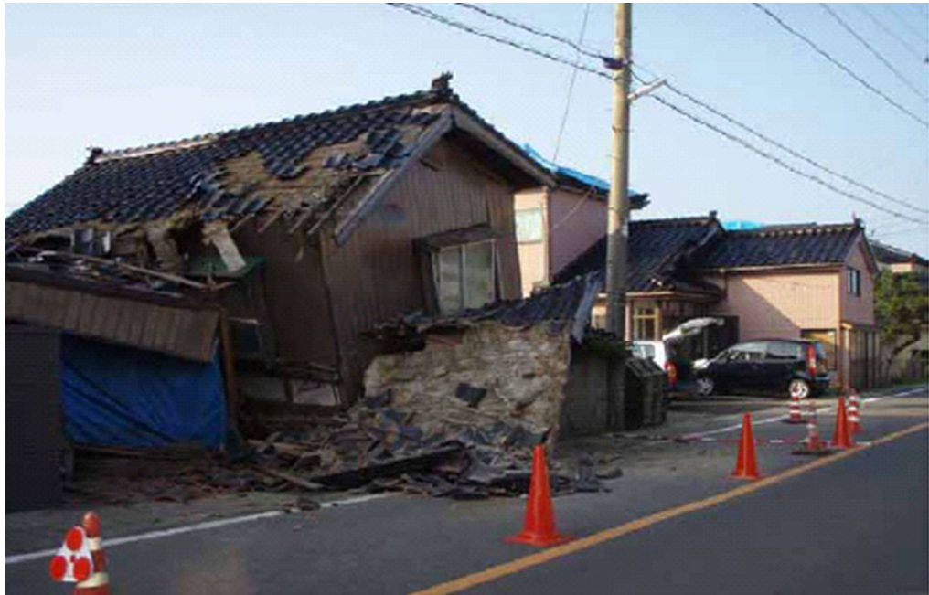
地震により倒壊した家屋
