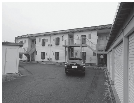
▲ 羽生田小学校教員住宅
