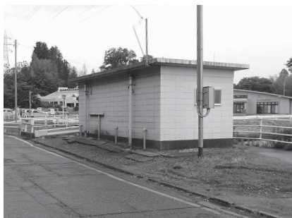
▲ 原ヶ崎運動広場トイレ
