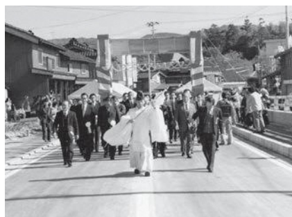
▲羽生田跨線橋開通(昭和55年11月)
