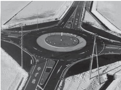
▲県内初の環状交差点（ラウンドアバウト）開通（平成28年2月）
