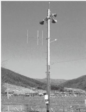
町内の主要な避難所及び土砂災害警戒区域及び信濃川の浸水想定区域内の合計8か所に「屋外スピーカー」を設置します。屋外拡声子局は、スピーカーから広く緊急情報を周知できるほか、支柱に設置してある無線機を使用し、役場やその他の子局と双方で無線通話が可能です。令和2年3月末までに設置する予定です。
