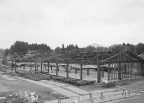
建設工事が進む幼稚園
