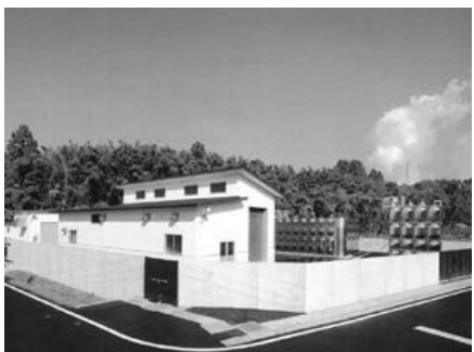
▲ 羽生田浄水場
