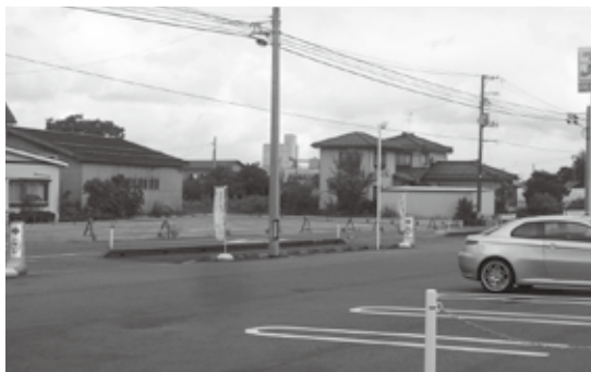
▲ 新店舗開業に伴う水道管移設工事
