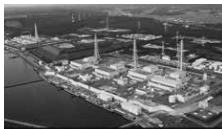
▲ 柏崎・刈羽原子力発電所
