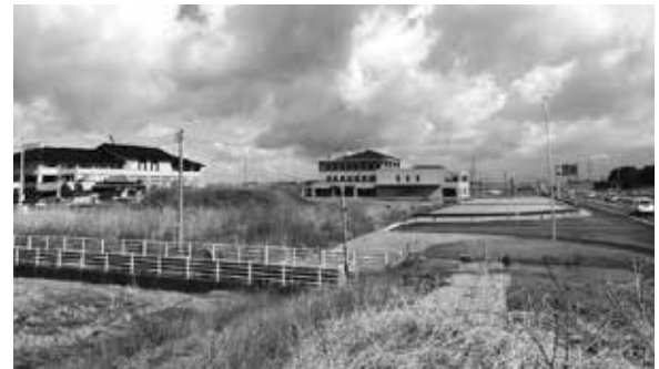
▲ 本格着工前の「道の駅たがみ」建設地
