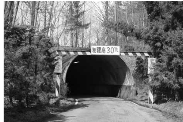
五明寺トンネル▶
