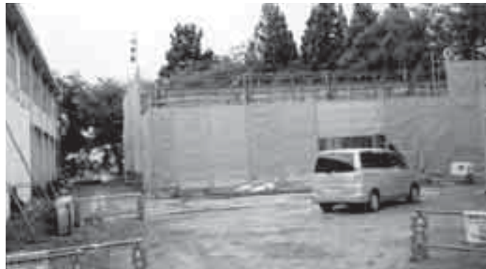
▲建設中の武道場
