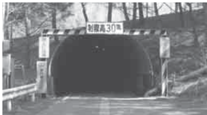
▲五明寺トンネル
