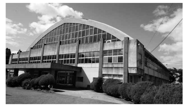
▲ 1973年度に建設され、老朽化が進行している町民体育館
