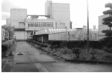
▲ 田上終末処理場設備更新工事に着手
