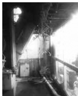
▲清掃センター内部
