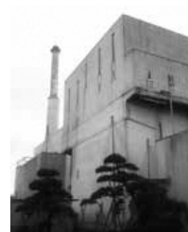
▲清掃センター外観
