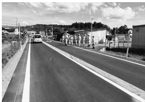
▲舗装補修後の川船河・西9号線
