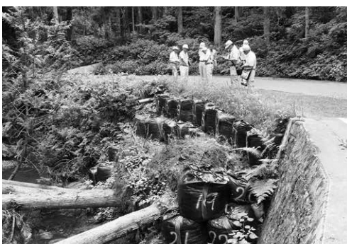
▲林道護摩堂線災害復旧現地調査
