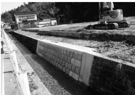
▲ 29年水害の護岸復旧工事
