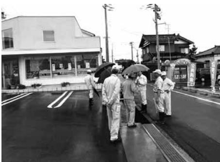
▲大郷7号線側溝改良工事現場
