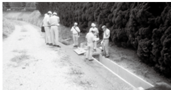
▶ 中江川支流河川改良工事
