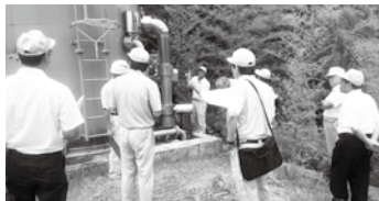
▶ 上水道送水管布設工事
