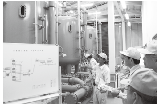
▲羽生田浄水場
