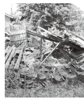
▲倒壊した空き家
