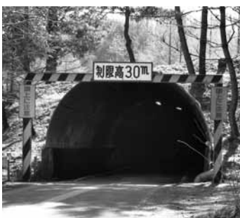
▲五明寺トンネル
