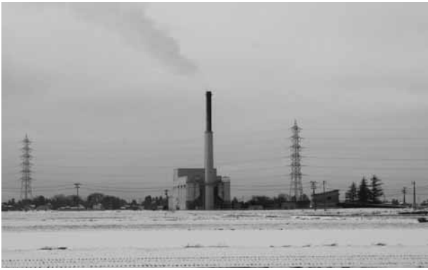
▲加茂市・田上町消防衛生組合清掃センター
