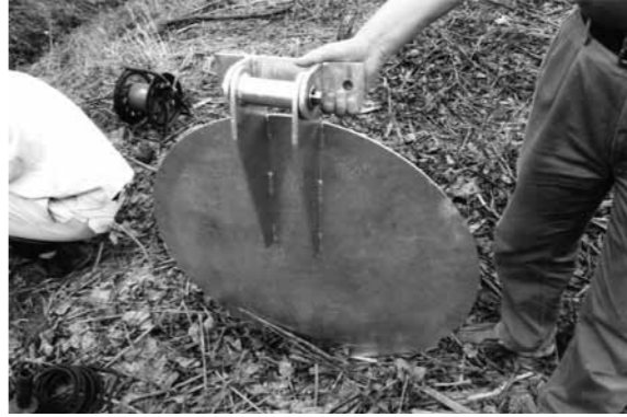
▲交換したフラップゲート(保明嶋)
