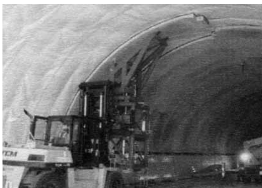
プレキャスト版設置状況
