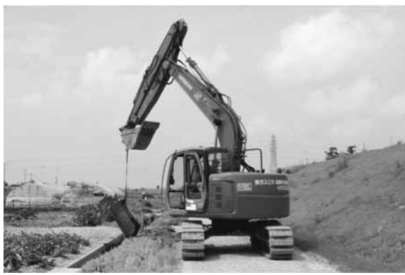
▲水害復旧工事現場
