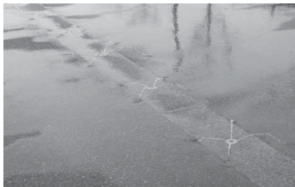
▲稼働中の消雪パイプ
