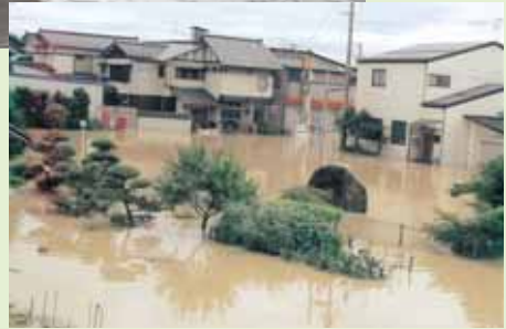
▲保明嶋地区の浸水状況
