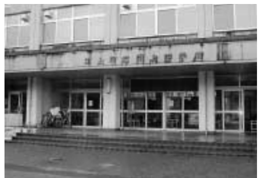
雨漏りの修理をした田上中学校
